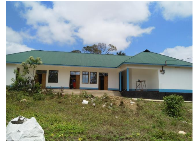
Mutter-Kind-Klinik in Mahenge im September 2018. Der Innenausbau ist fertig, Elektrischer Strom und Warmwasser sind verfügbar.
