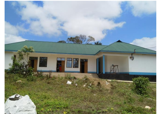
Mutter-Kind-Klinik in Mahenge im September 2018. Der Innenausbau ist fertig, Elektrischer Strom und Warmwasser sind verfügbar.
