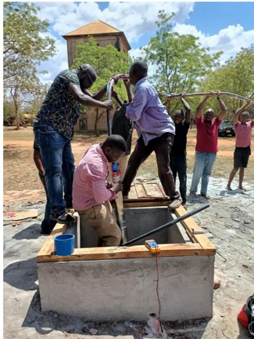
Die Unterwasserpumpe wird eingebaut.
