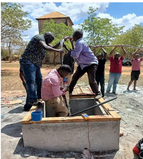
Die Pumpe für den neuen Tiefbrunnen in Tunduru wird installiert (12/2021)
