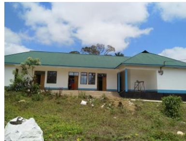
Mutter-Kind-Klinik in Mahenge im September 2018. Elektrischer Strom und Warmwasser sind verfügbar.
